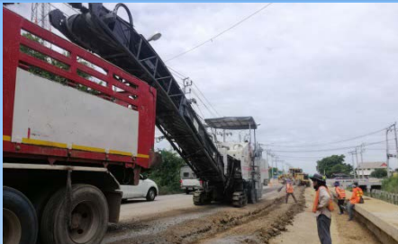
ดำเนินการรื้อผิวจราจรเดิม
