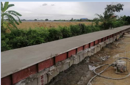
ดำเนินการเทคอนกรีตทางเท้า
