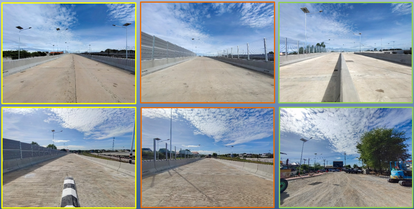
โครงการก่อสร้างสะพานข้ามทางรถไฟ จุดตัดทางรถไฟกับถนนสาย นรฐ. ๑๐๒๓ แยก ทล.๔ – บ้านวัดละมุด อำเภอเมือง , นครชัยศรี จังหวัดนครปฐม
